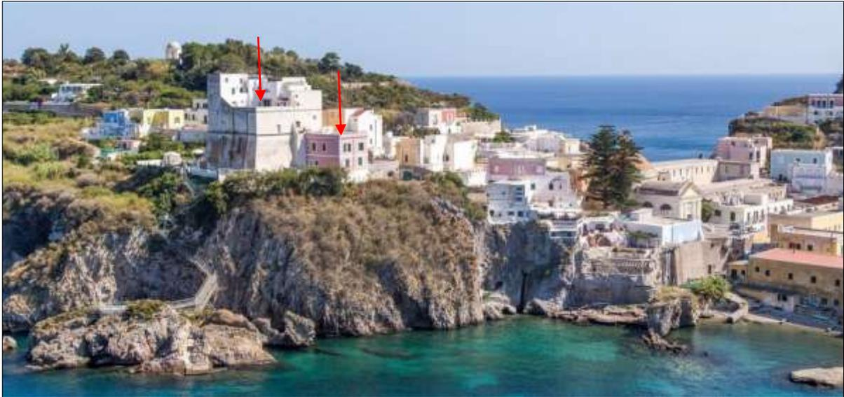
*Foto 7 – Le falesie al lato del porto. Con le frecce rosse sono indicati due edifici ricadenti nel Piano particolareggiato ed individuati a rischio R4 nel PAI. L'edificio rosa risulta sufficientemente arretrato dalla parete da non poter essere interessato da eventuali crolli (foto 2014© Geotag Aeroview).*
