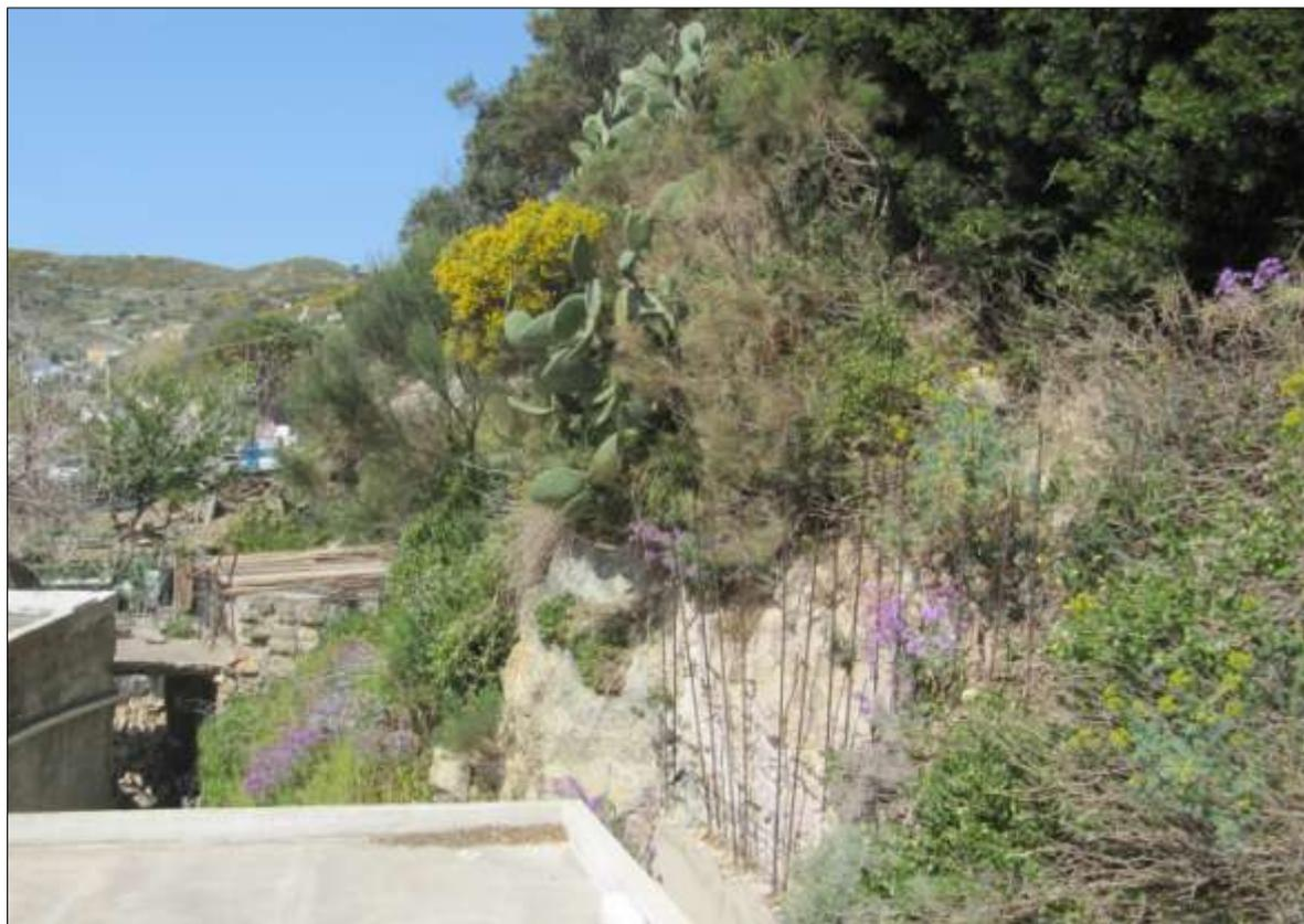
*Foto 17 – Scarpata in roccia alle spalle degli edifici sulla S.P. 134. Si nota la vegetazione che, con le sue radici, tende ad allargare le fessure della roccia. Si osserva anche una sottomurazione in cemento armato in corso di realizzazione.*
