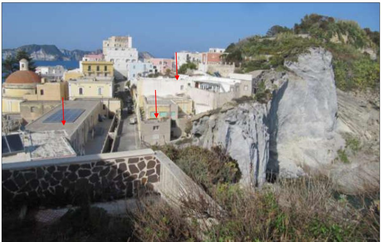
Foto 6 – L'area della foto 5 vista da terra con le frecce che indicano i medesimi edifici. Si nota che solo l'edificio al centro della foto è effettivamente in prossimità della falesia, mentre gli altri due risultano sufficientemente arretrati da non essere esposti al rischio di crollo, se non in un futuro molto lontano. La falesia antistante, tra l'altro, è in corso di consolidamento da parte del Comune.
