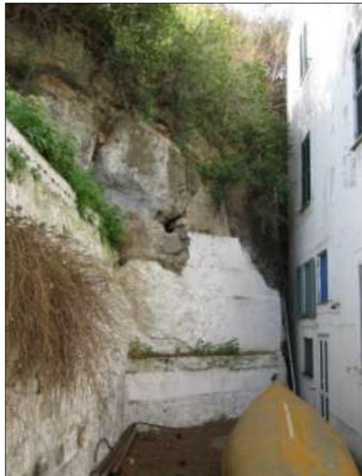
*Foto 10 – Scarpata in roccia a ridosso di un'abitazione sita lungo la via che porta al cimitero. La parte alta presenta fessurazioni che la vegetazione, con le sue radici, tende ad allargare.*
