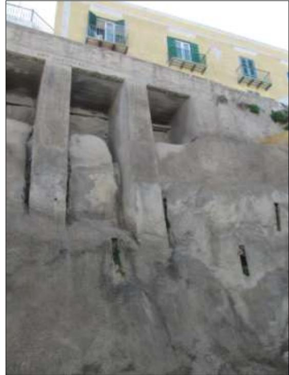
*Foto 2 e 3 - Scarpate verticali nella ialoclastite all'interno del centro storico, protette da muri in pietra ed in cemento armato, da contrafforti o rivestite con spritz beton.*
