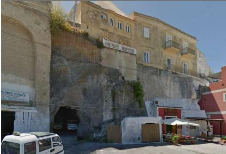
*Foto 9 – Scarpata in roccia nell'area portuale, di cui è stata protetta solo la parte alta costituita da detrito cementato; alla base della parete è presente una cavità artificiale adibita ad autorimessa.*
