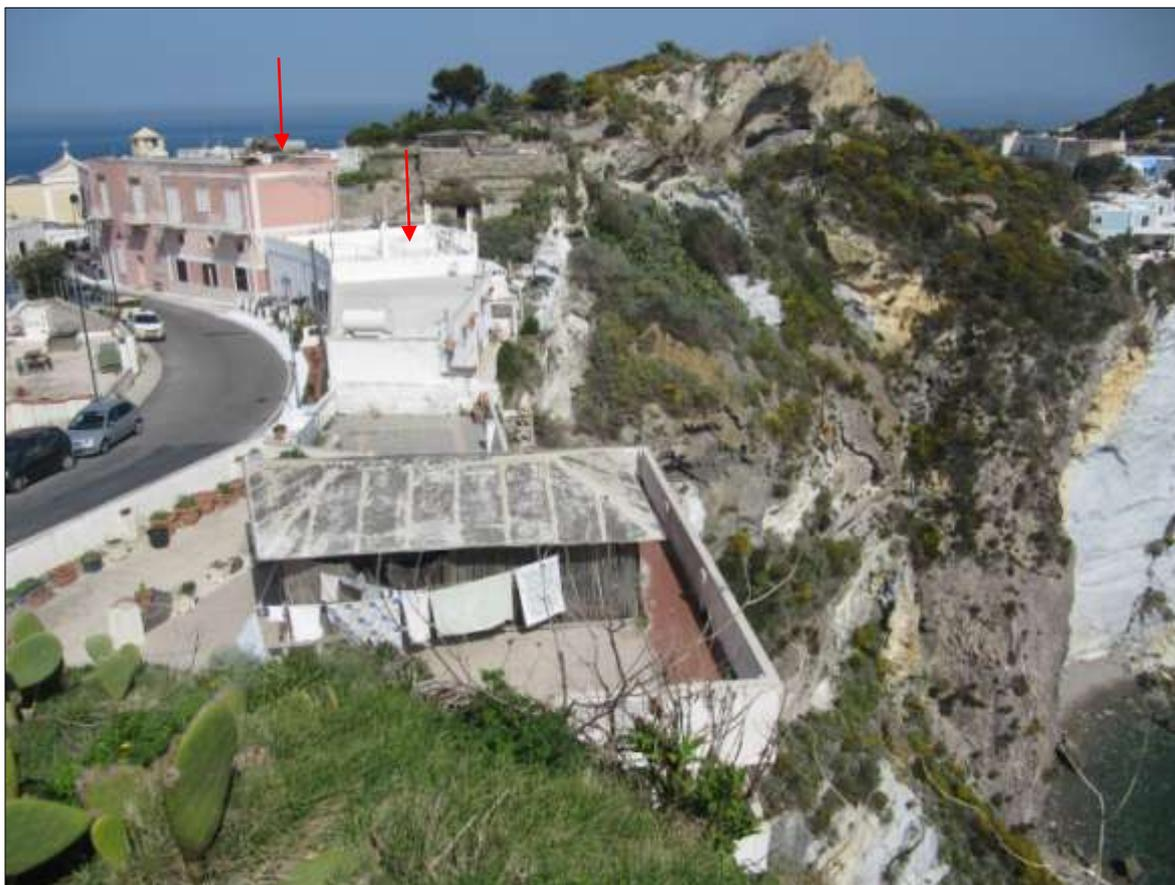
*Foto 23 – La falesia in prossimità della S.P. 134. Con le frecce rosse sono indicati alcuni degli edifici ricadenti nel Piano particolareggiato ed individuati a rischio R4 nel PAI. Si nota che solo l'edificio bianco è in prossimità della falesia, mentre quello rosa risulta sufficientemente arretrato da non essere esposto al rischio di crollo, né ha alle spalle una scarpata instabile poiché terrazzata.*
