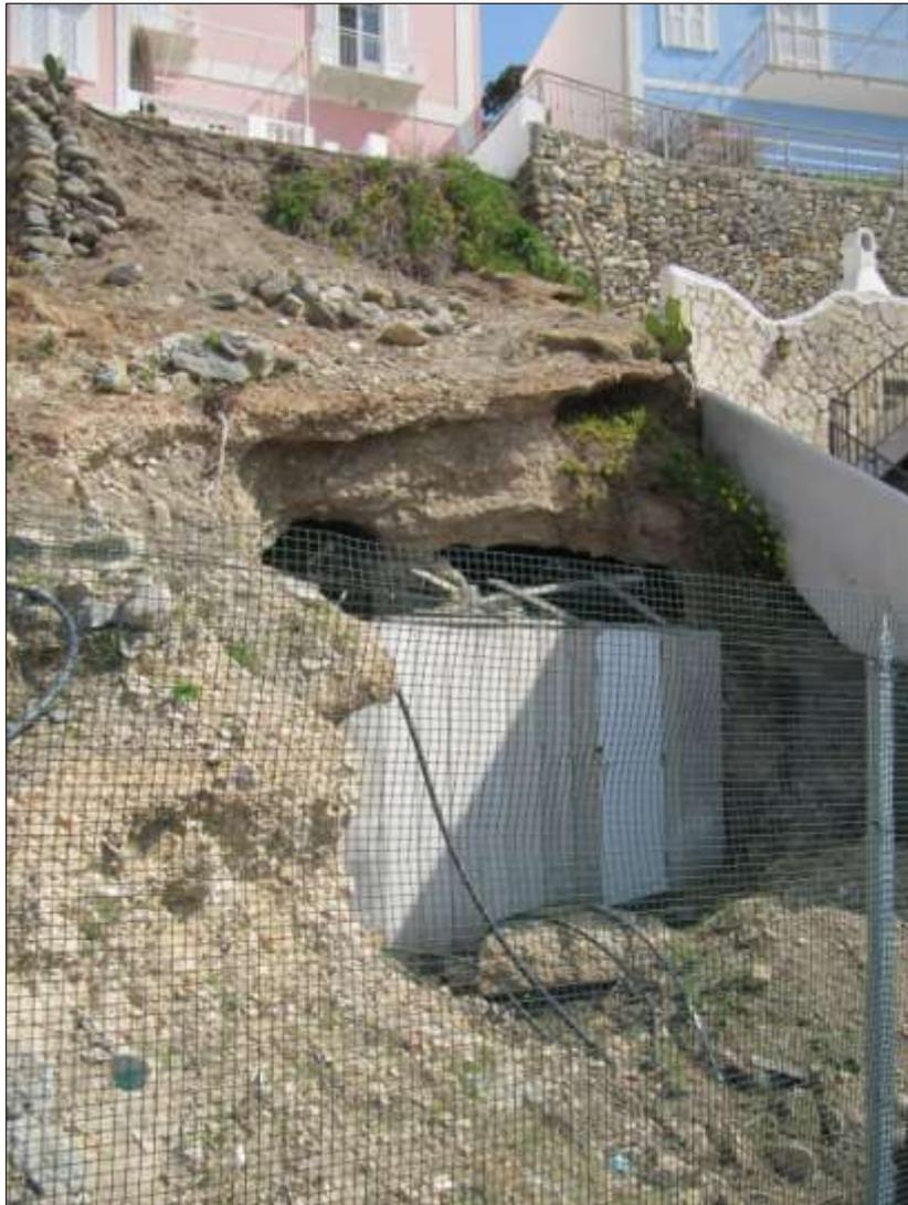
*Foto 18 – Cavità artificiale realizzata anticamente come magazzino o abitazione e parzialmente crollata.*
