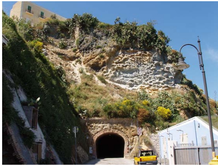
Foto 6 – Scarpata di falesia non protetta incombenente sull'accesso al tunnel stradale che conduce verso località Santa Maria.
